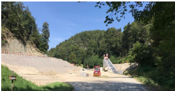
Blick auf Einlaufbauwerk
