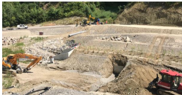
Blick auf den Damm/östliche Strasse
