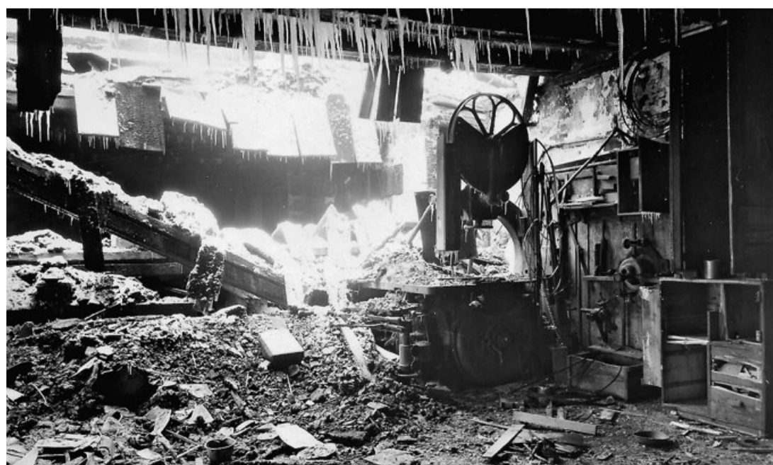
Die Werkstatt wurde eingäschert. Das Löschwasser gefror zu Eiszapfen.
