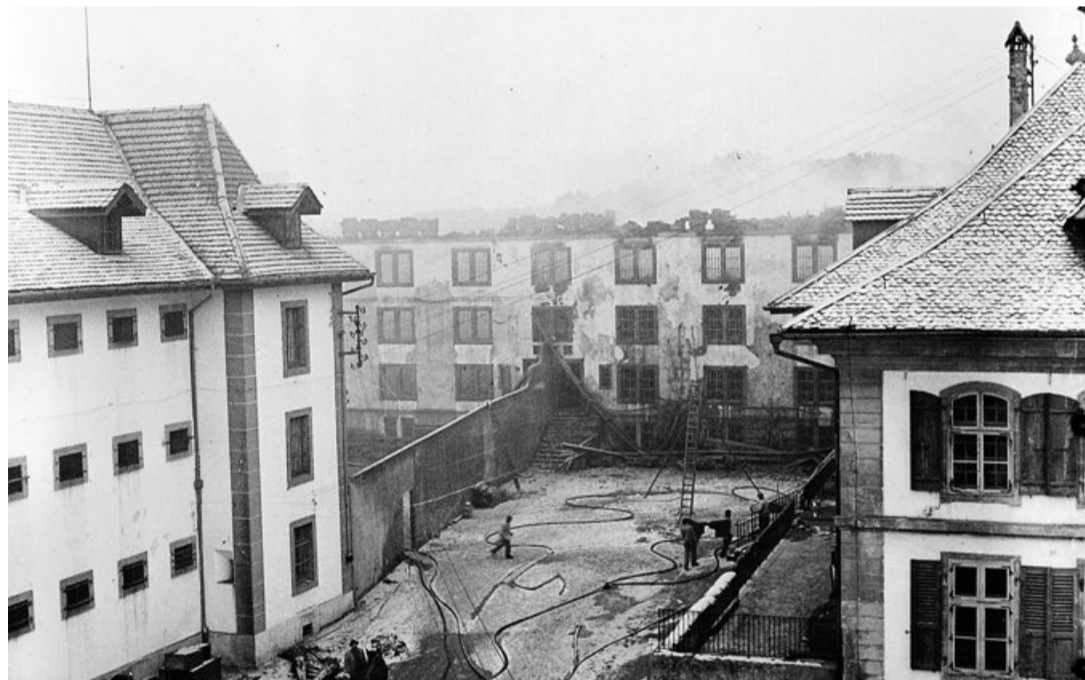
Das Korrektionshaus wurde zerstört, die übrigen Gebäude der Strafanstalt blieben unversehrt.
