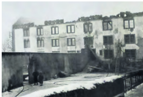
Thorberg-Gebäude nach dem Brand
